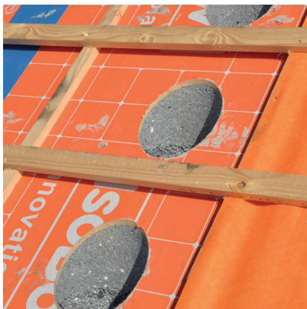
Fabrieksmatig aangebrachte, projectspecifieke doorvoer sparingen.
