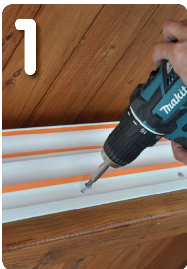
Randprofiel vastschroeven = luchtdichtheid
