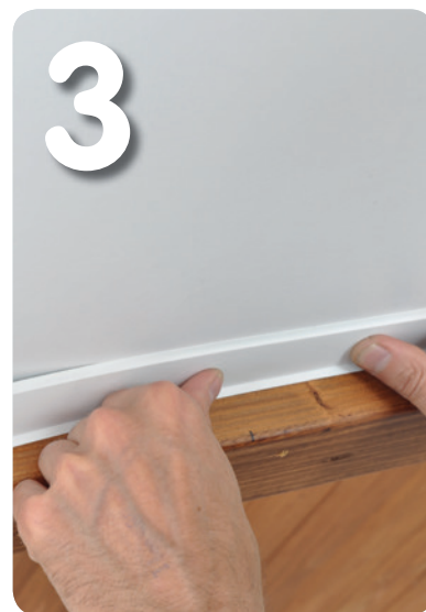
Klikprofiel bevestigen = esthetische afwerking
