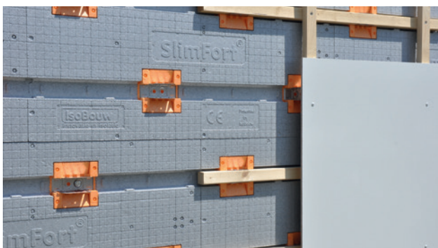
Afwerking met vezelcementplaten
