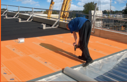
plat dak isolatie
