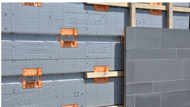
Afwerking met tegels
