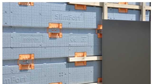
Afwerking met aluminium composietplaten
