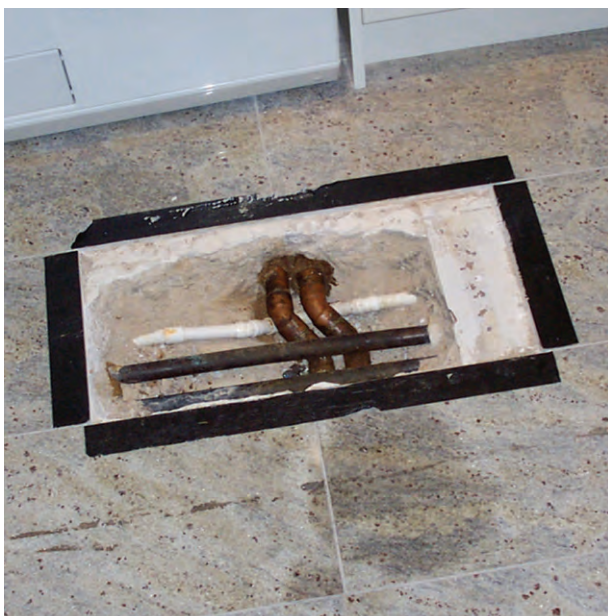
Een niet-destructieve oplossing voor het opsporen van lekkages.
