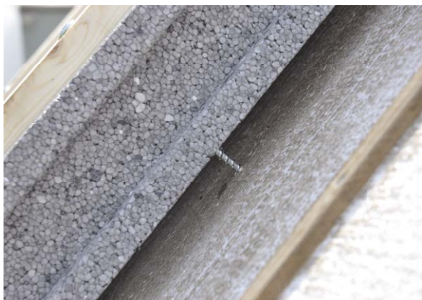
Speciale schroeven zorgen voor een constructief sterke, vrijdragende constructie
