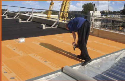
plat dak isolatie
